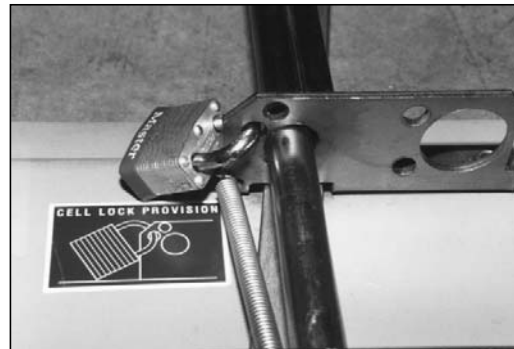
Figura 21: Receptáculo para el candado del mecanismo de inserción/extracción
