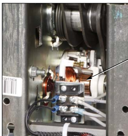
Figure 9 : Moteur d'armement des ressorts
